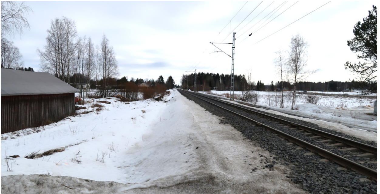
Kuva 4. Kuva Kirstantien ja Kirjurintien tasoristeyksen kohdasta itään (Ramboll 2024).
